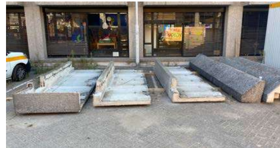
Gevelpanelen oude ABN gebouw
